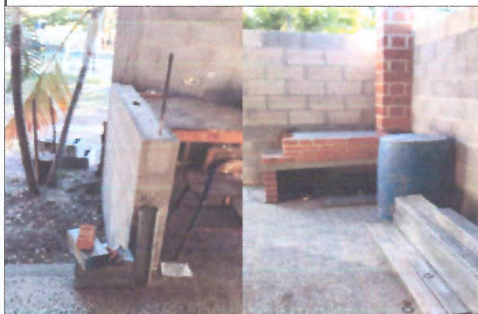
Foto 4: mejoramiento en cocina de leña, fundición de desayunador y colocar azulejo, barandal para evitar acceso de las alumnas al area de cocina
